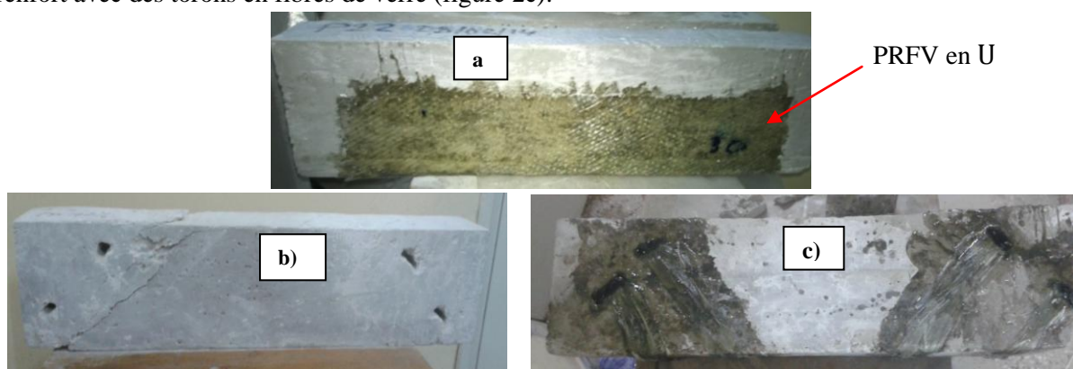
Figure 2 : Modes de réhabilitation : a) en forme de U ; b) perçage des poutres ; c) Méthode SCR.
